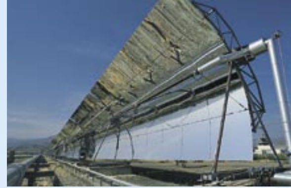
Parabolic trough collectors at Plataforma Solar de Almería.
